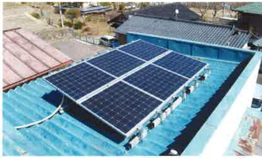
商工会に設置された太陽光発電設備「はつでんくん2号」
