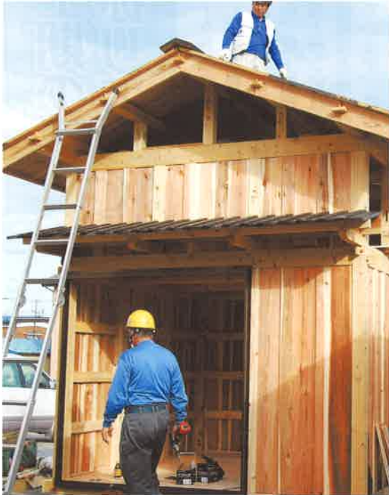
岩手県山田町に建設した木造建築物
